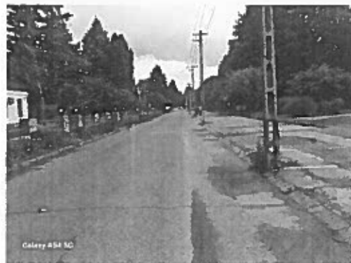
Közvilágítási oszlopok az úrszelvényen belül
