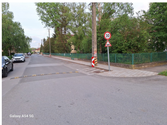
A sebességcsökkentő borda és előjelzése a Kőrösi Csoma S. u. irányából
