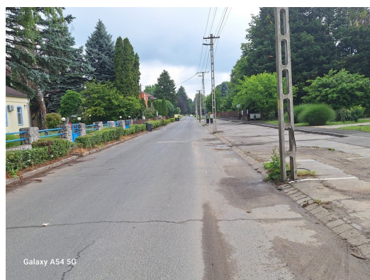
Közvilágítási oszlopok az úrszelvényben belül
