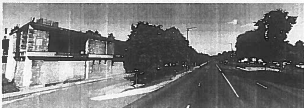
Az érintett ingatlan és a meglévő épülettorzó Kassuth utcai megjelenése (forrás: Google Earth)
